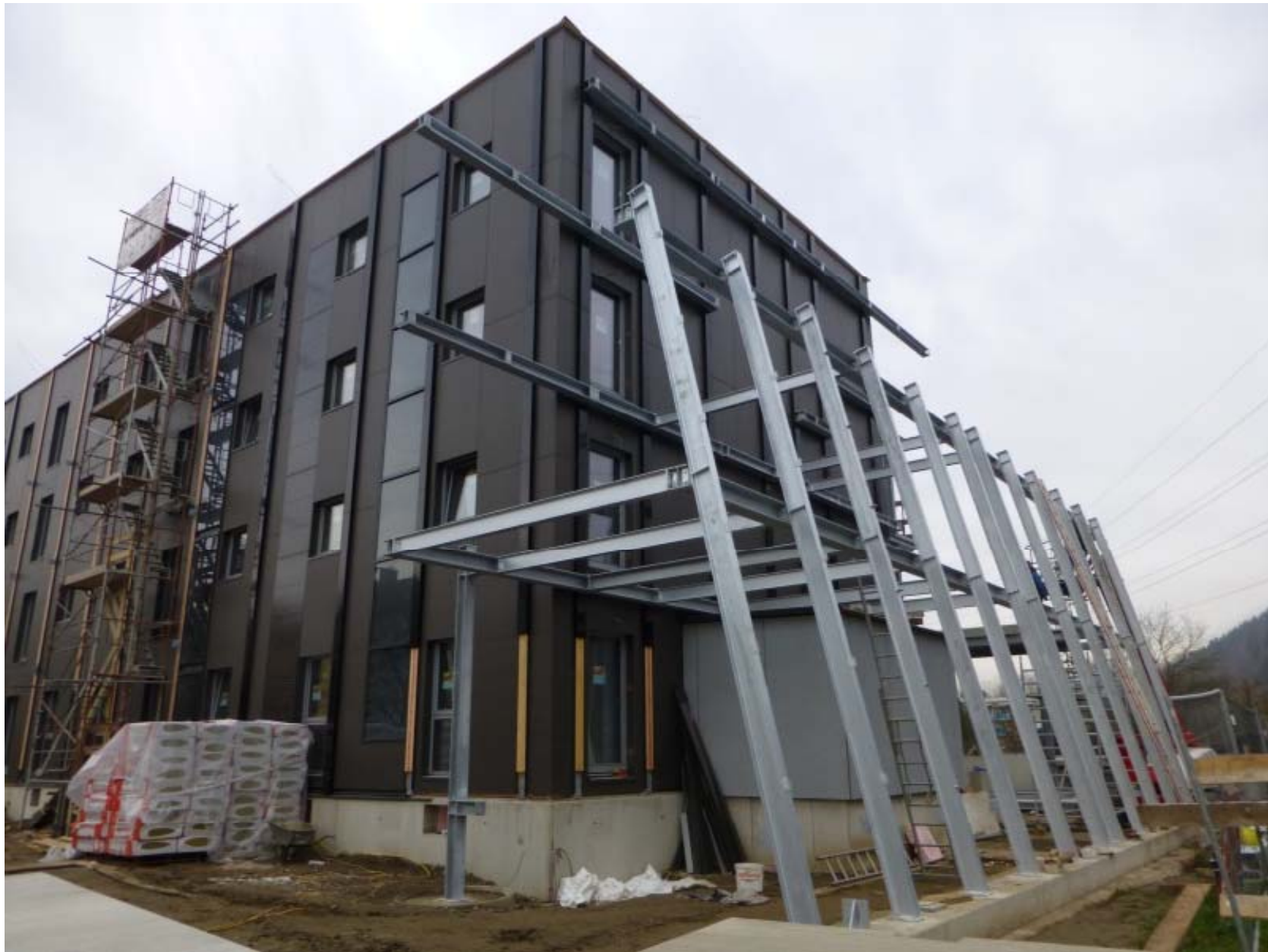
Plus-Energie-Sanierung Wohnhausanlage Johann-Böhm-Straße 34/36 in Kapfenberg: Ansicht Montage Sonnensegel (Foto: Karl Höfler, AEE INTEC)
