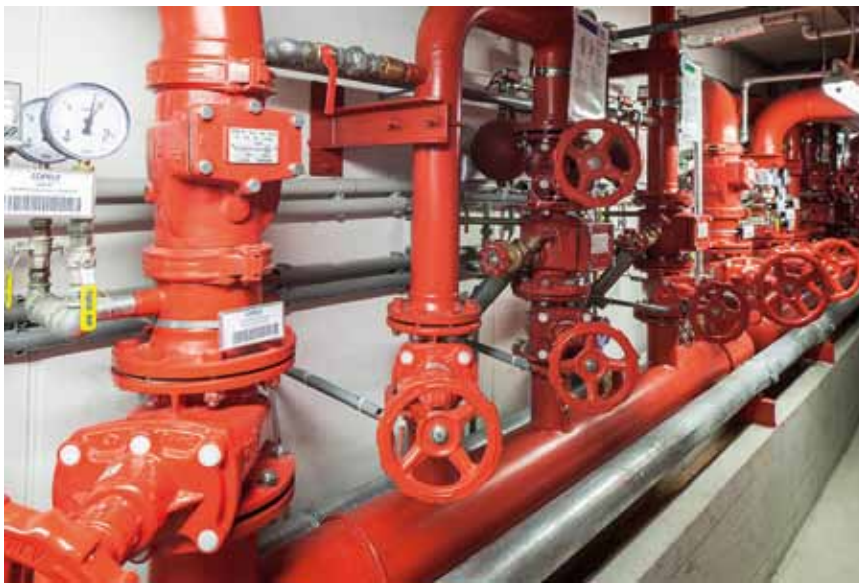
Sprinkleranlage
