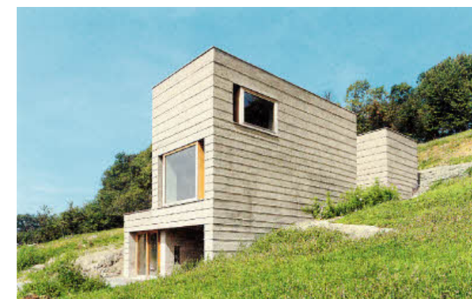
Ein Vorbild in Sachen Nachhaltigkeit: Diese Haus aus Lehm ist voll recycelbar. Als Baustoff wurde vor allem der tonigen Aushub verwendet
